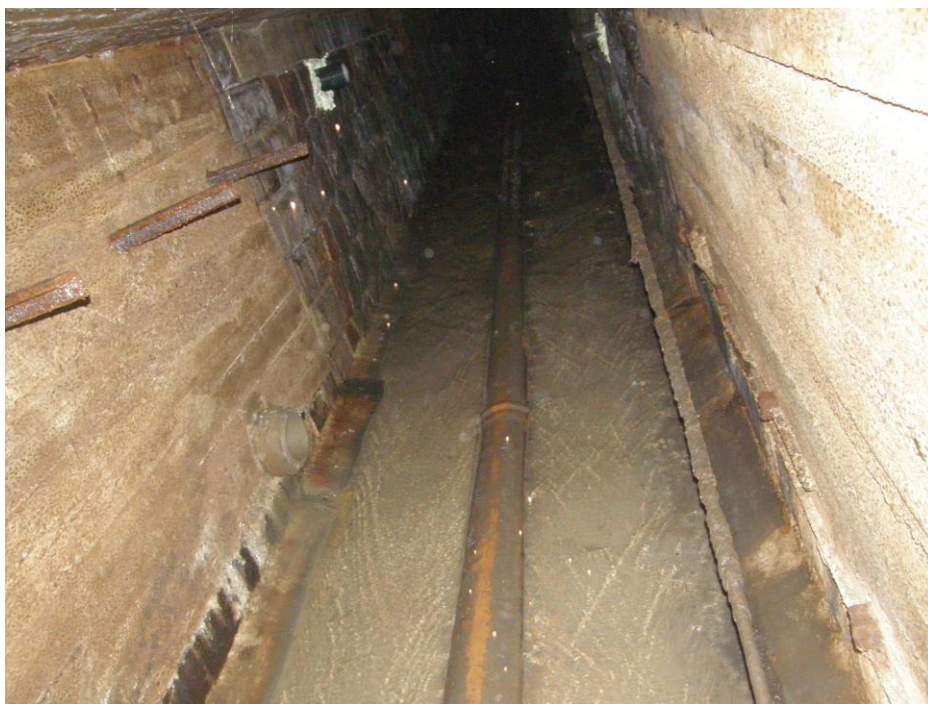
Obrázek 2 – Pohled uvnitř propustku, rozhraní kamenných a betonových opěr.
