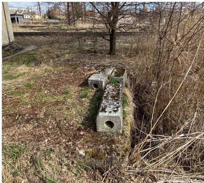
Obrázek 4 – Čelo propustku s drážním příkopem, umístěno vlevo kolejiště.
